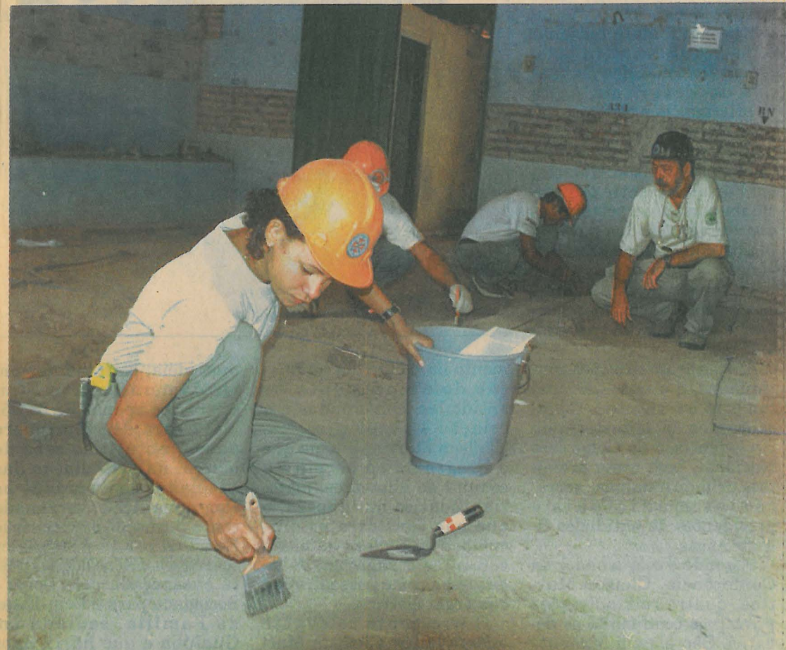
Escavações tiveram início no mês de outubro passado e agora estão sendo levantadas informações
